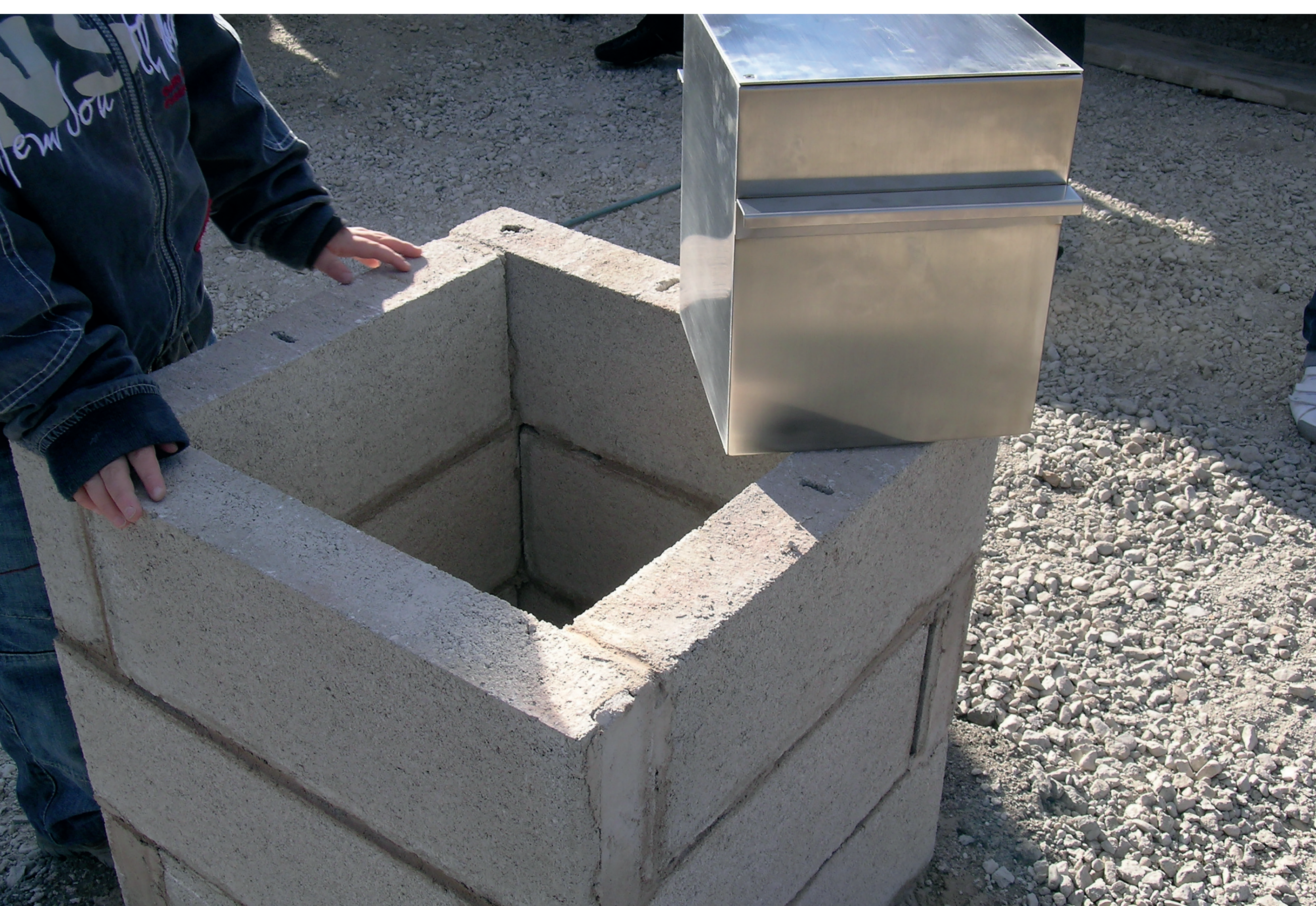
20.10.2007 – L'inserimento della "capsula del tempo" nelle fondamenta / Das Einfügen der „Zeitkapsel“ ins Fundament
