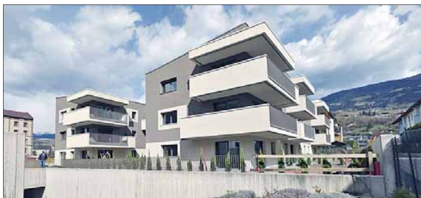
I 17 alloggi in cooperativa al Vinzentinum (Fotoservizio Fabio De Villa)
