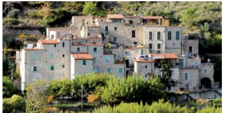
Die Mitglieder des Vereins Torri Superiore haben die einst verlassene Siedlung von Torri Superiore in Ventimiglia (Ligurien) auf eigene Faust wiederaufgebaut.
