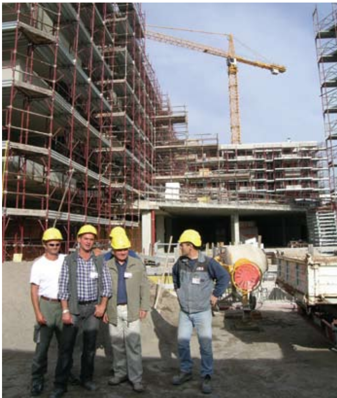
Operai C.L.E. al cantiere Firmian / Arbeiter der C.L.E. vor der Firmian-Baustelle
