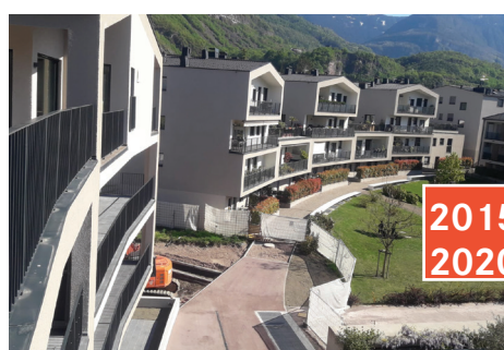
Gli edifici delle cooperative Myre 2015 e Coopeden 2020 ad Ora, sono caratterizzati da ampie terrazze, spazi comuni, giardini e aree per il gioco o l'incontro.
